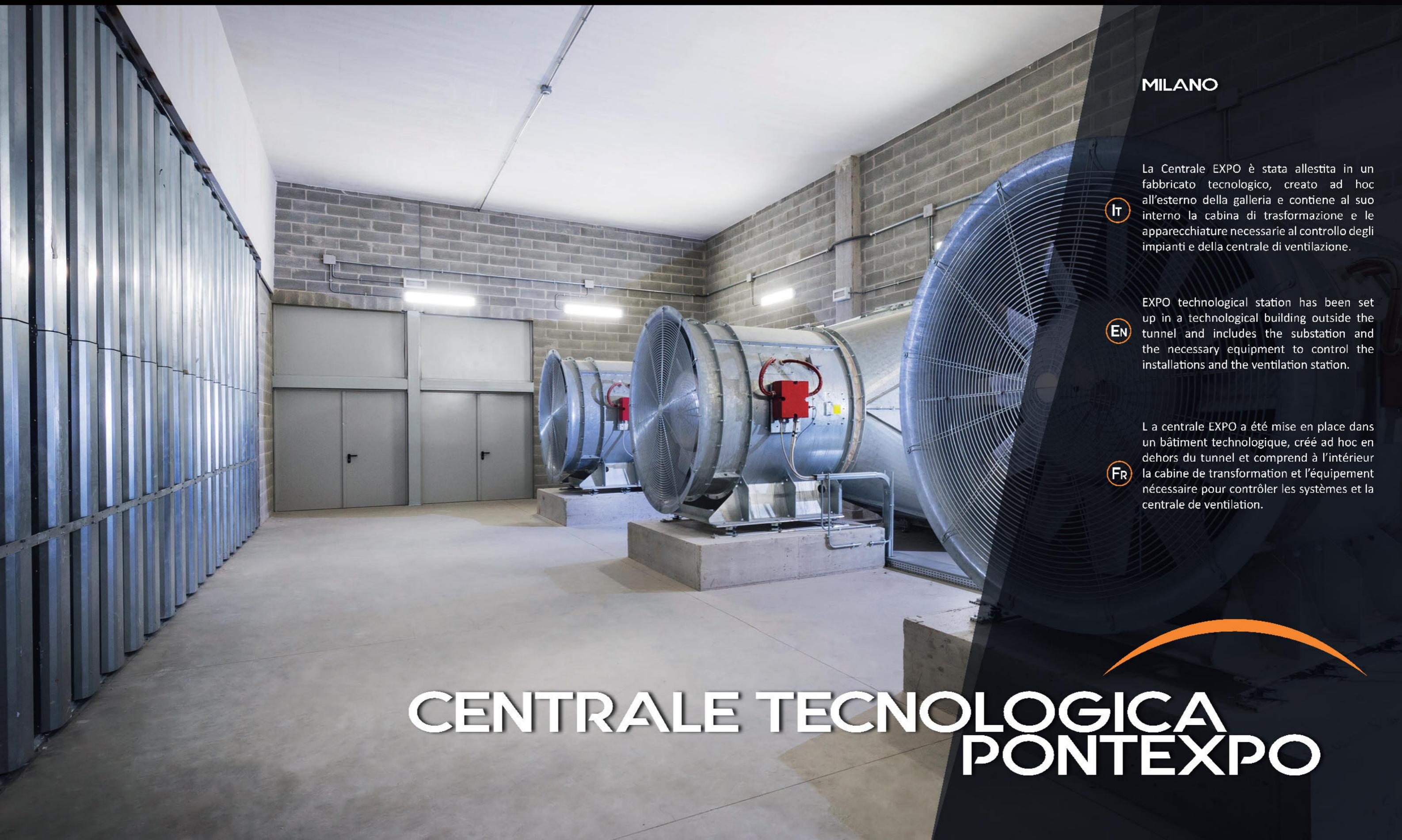
La Centrale EXPO è stata allestita in un fabbricato tecnologico, creato ad hoc all'esterno della galleria e contiene al suo interno la cabina di trasformazione e le apparecchiature necessarie al controllo degli impianti e della centrale di ventilazione.
